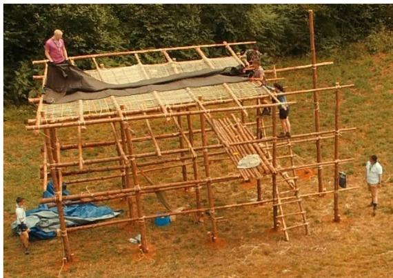
*Construction de la structure d'un pilotis, afin de pouvoir mettre les tentes en hauteur.*
